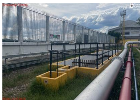
ภาพที่ 9 บ่อดักคราบน้ำมัน Oil interceptor เพื่อทำการแยกน้ำมันออกจากน้ำก่อนระบายสู่ลำรางสาธารณะ
