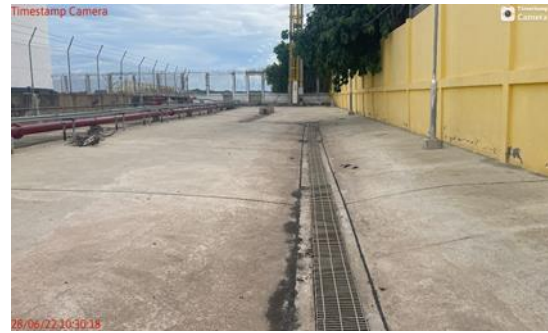
ภาพที่ 2 รางระบายน้ำคอนกรีตภายในคลัง
